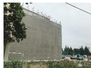
西側ベランダの取り壊し作業
